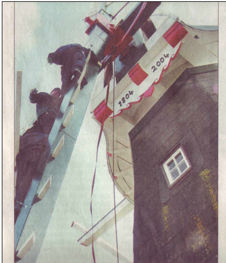
Fachleute waren gestern mit der Montage der Flügelemente an der Serierner Mühle beschäftigt. FOTO: KIESÉ
