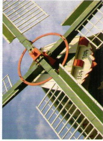
Der Willms'sche Kreuzversteifungsring sorgt für zusätzliche Stabilität des Flügelkreuzes im Achskopf. Er wurde 2006 wieder eingebaut.
